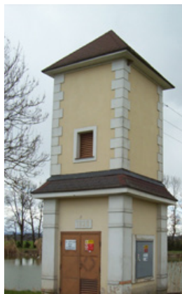
▲ Transformátor v Pašicích z roku 1928, který svému účelu slouží dodnes.
