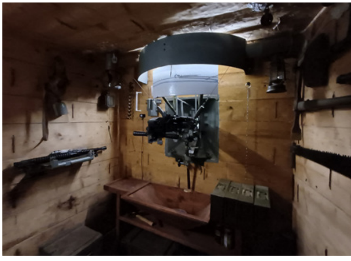
Interiér lehkého opevnění
