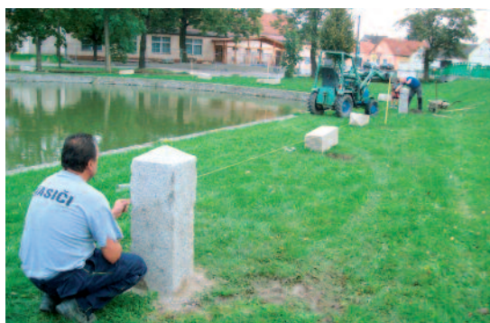
Sázení kamenů kolem požární nádrže v Češnovicích
