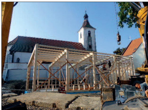
Mateřská škola ve výstavbě
