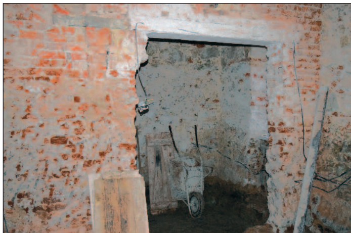
Začátek rekonstrukce 29. ledna 2018
